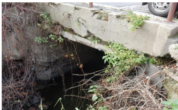
Obr.12: Degradovaná nosná konstrukce
