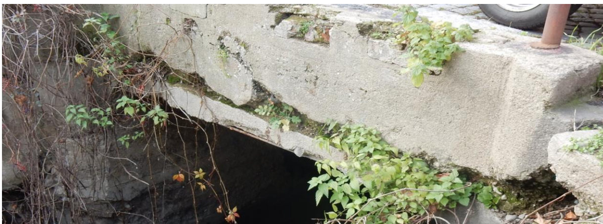
Obr.16: Pohled na degradovanou římsu
