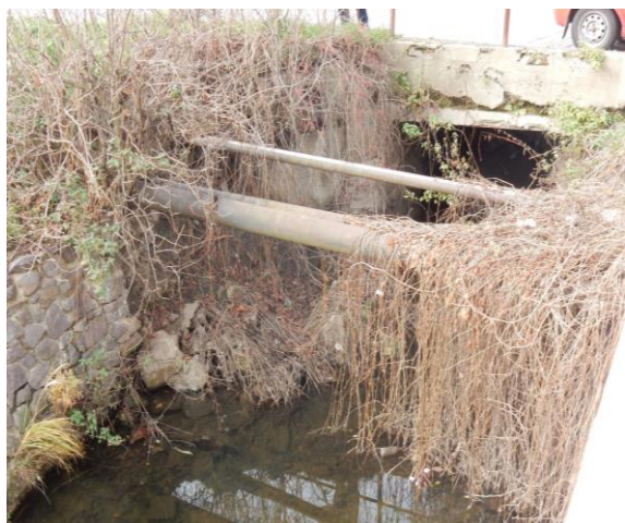
Obr.5: Vyvalené zdivo nábřežní zdi
