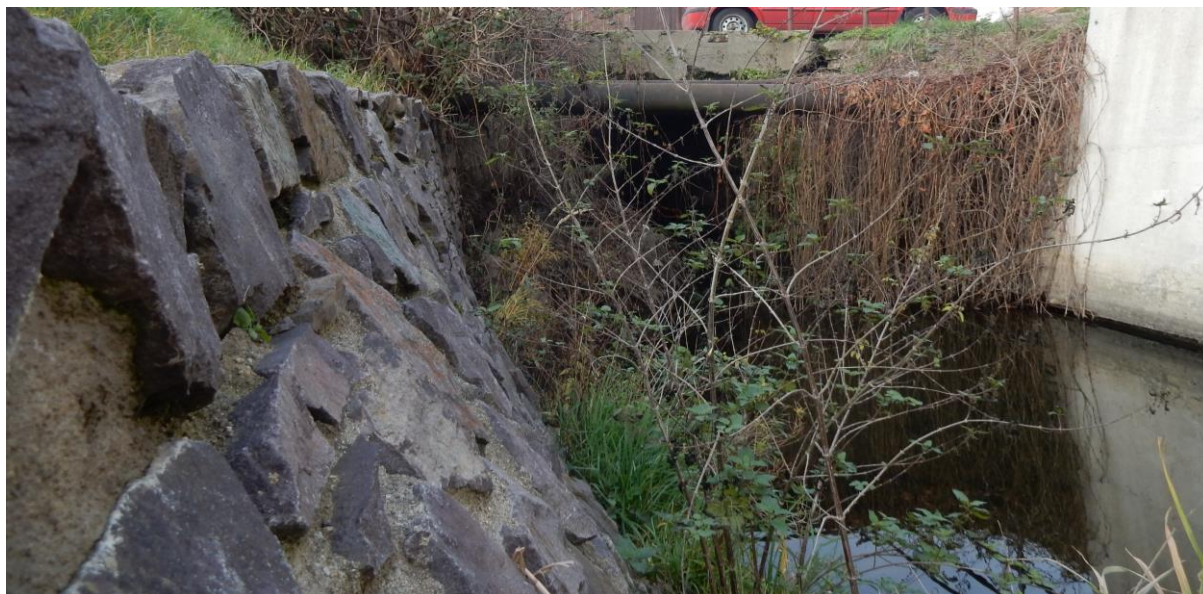
Obr.3: Pohled na degradované opěry a nábrežní zdi a opěry
